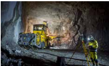
En borrhög gör sig redo att borra inför en sprängning. Inför varje sprängning borras ca 130 hål i berget. De ca fem meter djupa borrhålen fylls sedan med sprängämnen. En mättekniker hjälper till att navigera så borrhålen hamnar exakt rätt.
