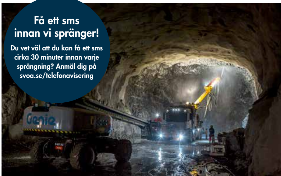
Förstärkning med sprutbetong
