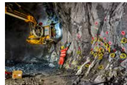
Laddning inför sprängning
