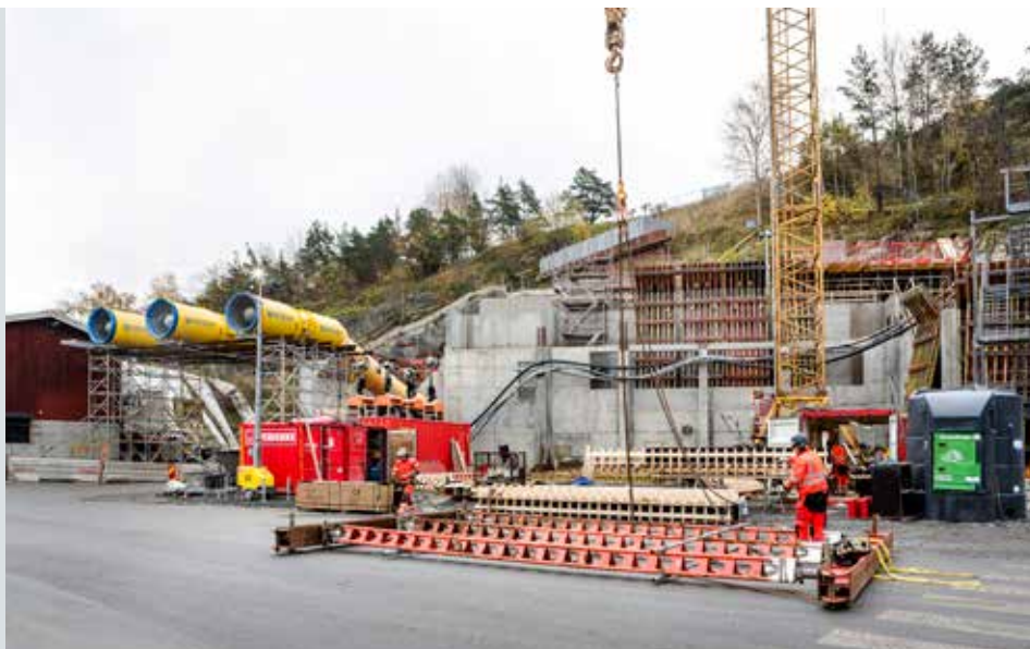
Betongarbeten utanför tunnelmynningen i Hammarbybacken
