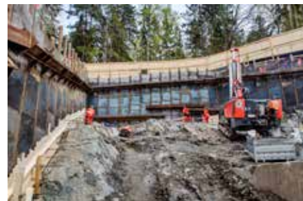
Spontning vid tunnelpåslaget i Åkeshov
