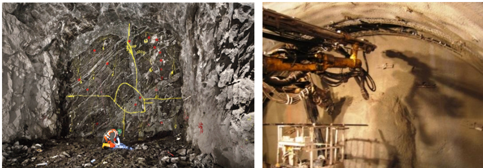
Figur 7. Exempel på konventionella drivningsmoment: laddning respektive förstärkning med sprutbetong.
