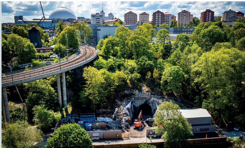
Från byggetableringen vid Sundstabacken norr om Gullmarsplan sprängs en arbetstunnel ned till avloppstunneln fram. Under hösten 2021 är sprängningarna vid Gullmarsplan pausade.
