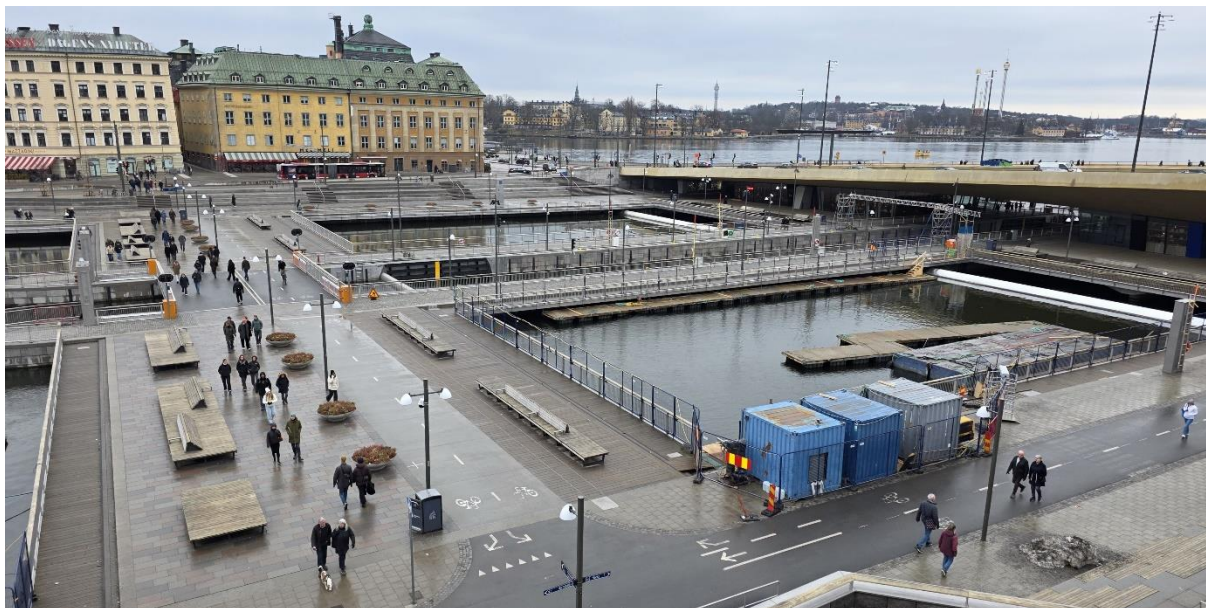
Vattentorget vid nya Slussen i mars 2026. Foto: Joakim Lücke.
