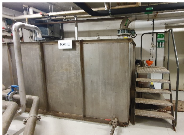
Figur 3.2. Den varma och den kalla bassängen i kylsystem B.
