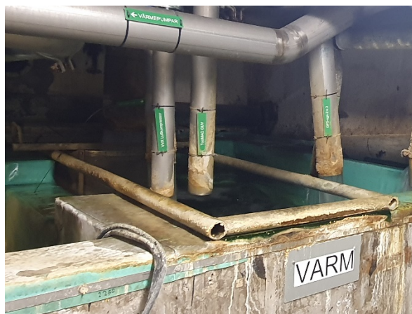
Figur 3.2. Den varma och den kalla bassängen i kylsystem B.
