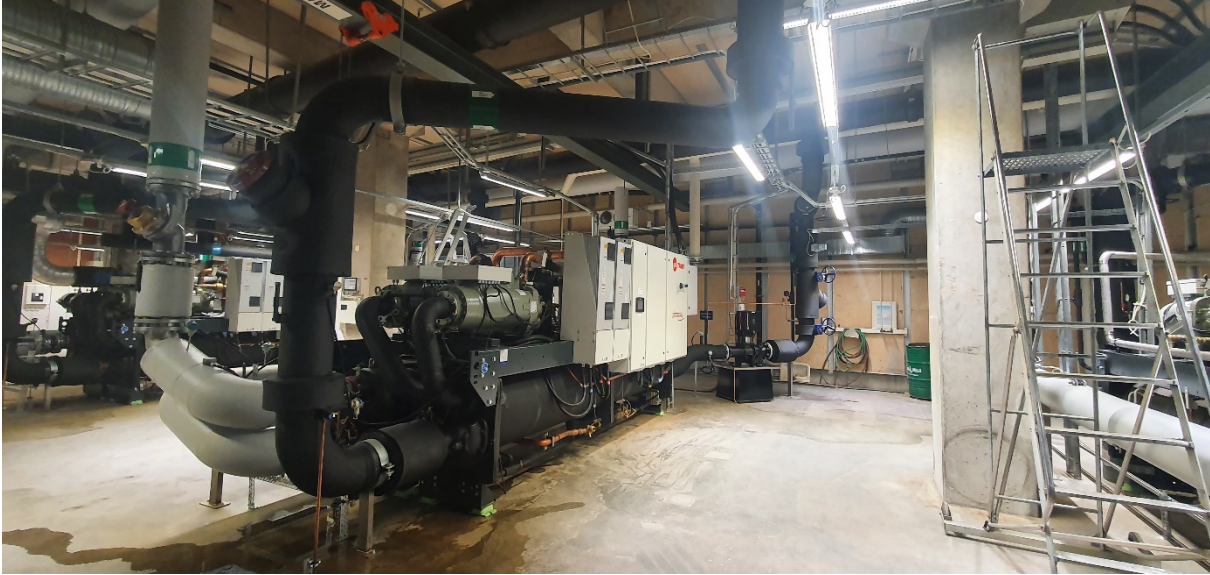
Figur 3.7. Kylmaskin i tryckeriets kylsystem.
