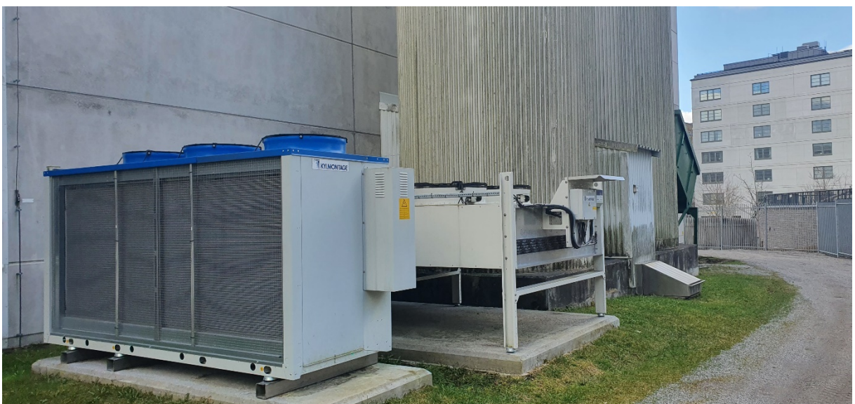
Figur 3.6. Fläktarna som avleder värmen utomhus.
