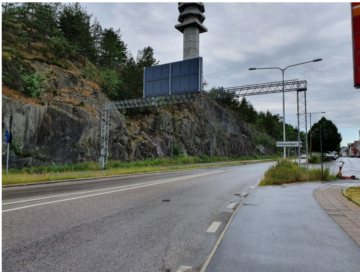
Figur 10.1 Bergvägg vid Hammarbyvägen, sett österifrån.
