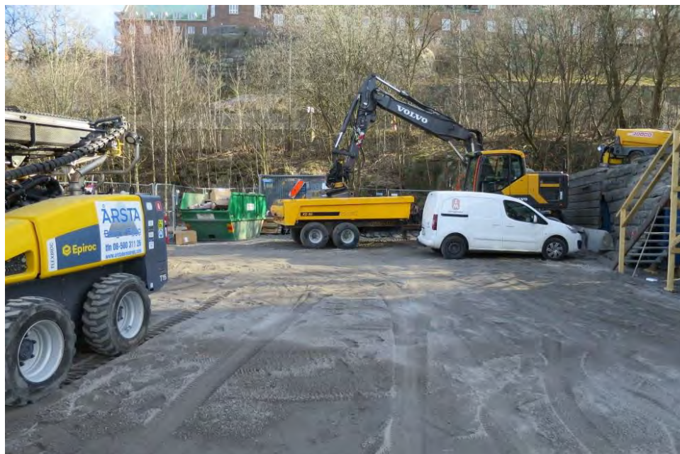
Figur 26. Befintlig situation sett från tunnelpåslagets arbetsområdes norra del.
