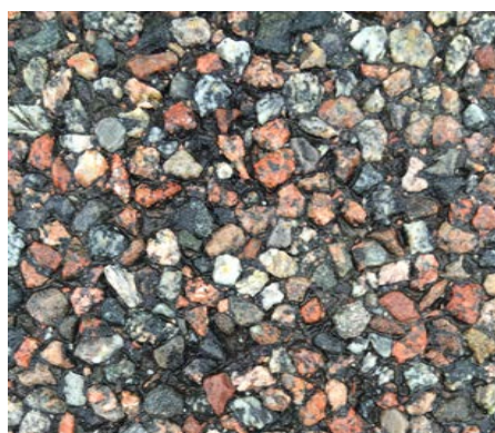
Genomsläpplig asfalt före (ovan) och efter (nedan) tvättning och vakuumsugning.
