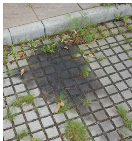
Oljespill som binds i beläggning och övre marklager kommer så småningom att brytas ner.
