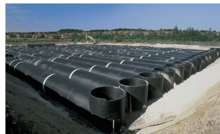
Avsättningsmagasin kan platsgjutats eller anläggas med hjälp av prefabricerade element. Ovan ett rörmagasin i plast.
