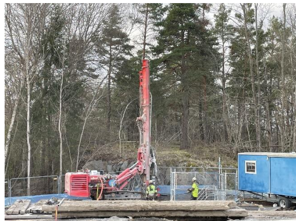
Bild tagen i våras i samband med våra markarbeten.
