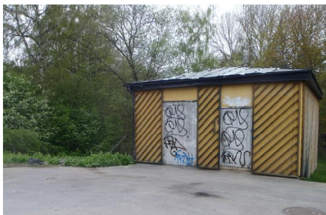
Befintlig luftreningsstation som kommer att ersättas med ny.
