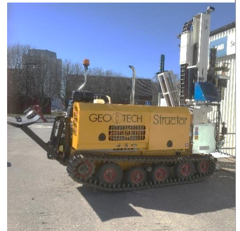
Stockholm Vatten och Avfall undersöker marken i ditt område. Arbetet görs med hjälp av en bandvagn som du ser på bilden.
