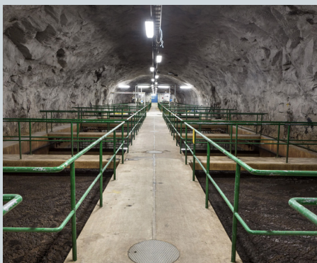
Eftersedimenteringsbassäng som ska byggas om till membranbassäng
