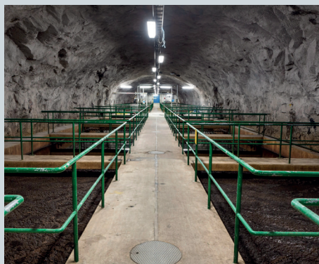
Eftersedimenteringsbassäng som ska byggas om till membranbassäng
