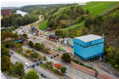
Sicklaanläggningen byggs ut för att rymma grovning, sandfång samt försedimentering.
