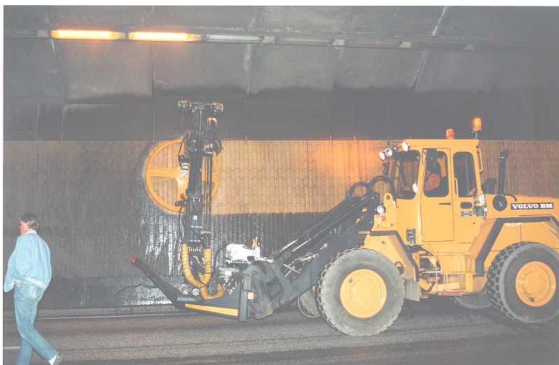
Spolning av Fredhällstunneln
