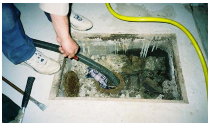
En renslucka har öppnats i källargolvet.
