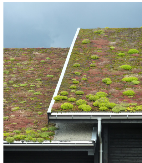
Exempel på vegetationsklädda tak i olika skala. Till vänster en takträdgård med vegetation i olika nivåer, till höger ett extensivt grönt tak med en tunn matta av torktåliga växter.
