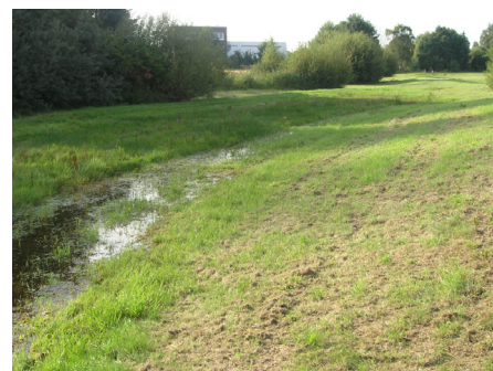
Ovan och nedan exempel på större överdämningsytor/torra dammar med ut- och inlopp via ett dike.
