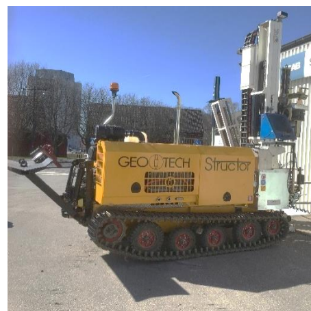
Stockholm Vatten och Avfall undersöker marken i ditt område. Arbetet görs med hjälp av en borrhandsvagn som du ser på bilden.
