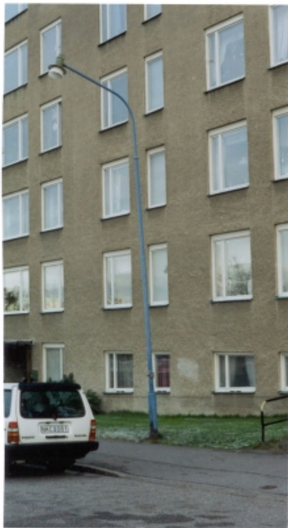
Figur 11: Blåmålad förzinkad lyktstolpe Höjd 7,2 m. Exponerad area 1,8 m 2 .
