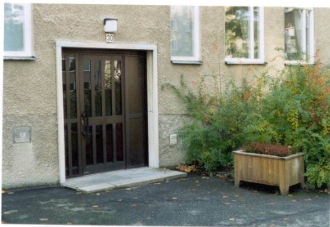
Figur 16: Blomlåda i impregnerat trä, exponerad area 1,8 m 2 . Portgaller framför port, exponerad area 3,1 m 2
