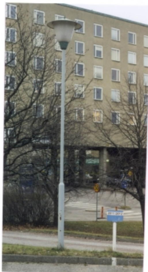
Figur 10: Målade förzinkade lyktstolpar. Höjd 3,7 - 4 m. Exponerad area ca 0,85 m 2 .
