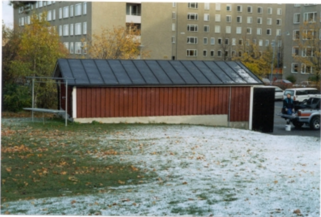
Figur 5: Förråd/miljöstuga. Bandlackerat tak.
