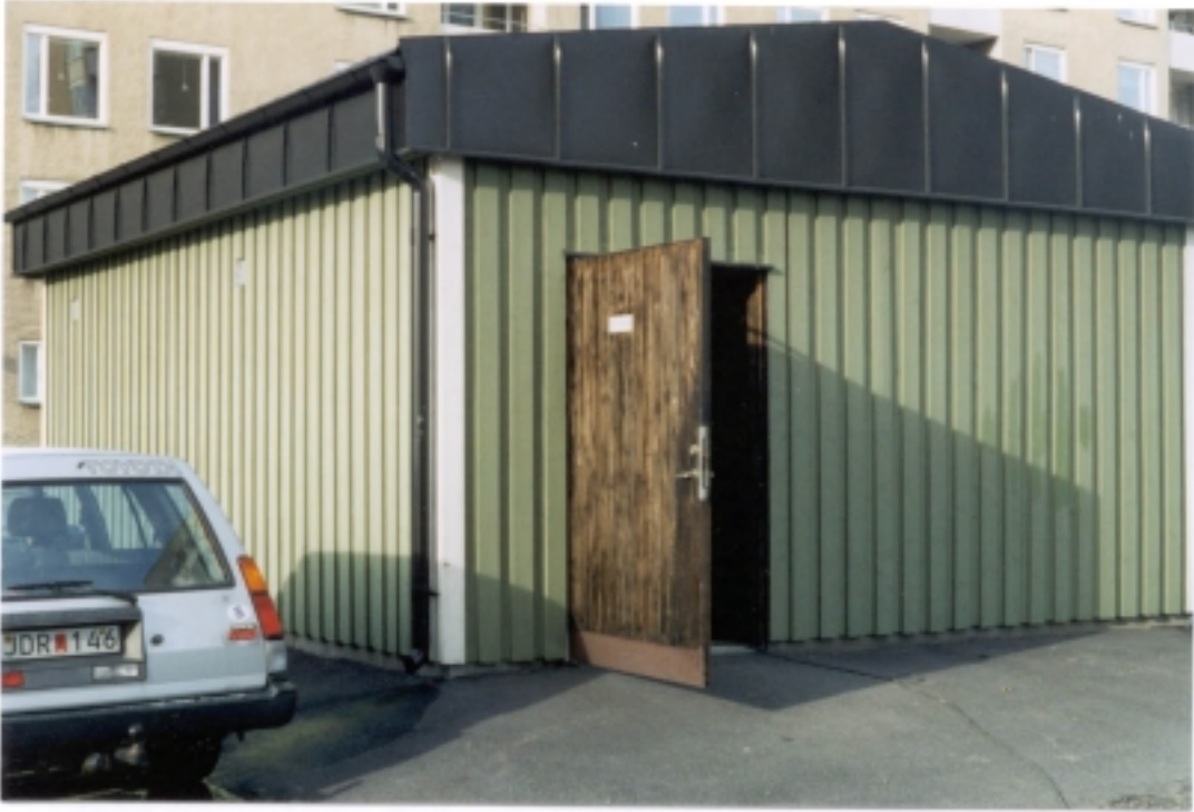
Figur 4: Förråd/miljöstuga. Bandlackerat tak??
