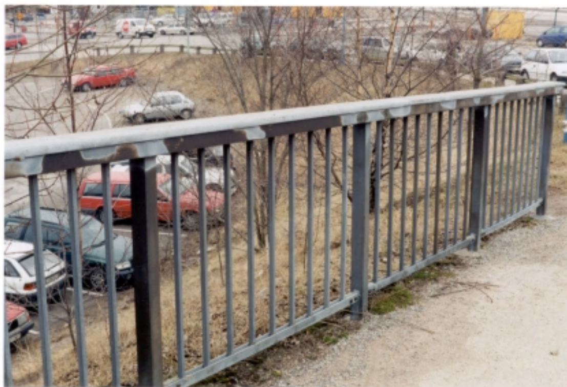
Figur 9: Förzinkat vägräcke. Exponerad yta: 1,6 m 2 per meter
