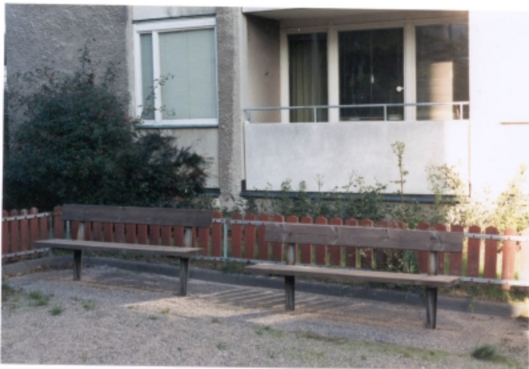
Figur 13: Parkbänkar. Bräder per bänk, exponerad area 1,5 m 2 . Förzinkade hållare per bänk, exponerad area 0,7 m 2 .
