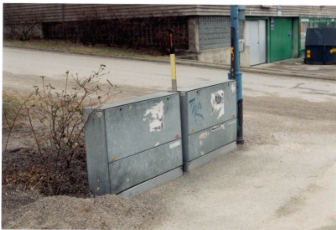
Figur 14: Förzinkade elskåp. Exponerad area per bänk skåp 1,6 m 2 .
