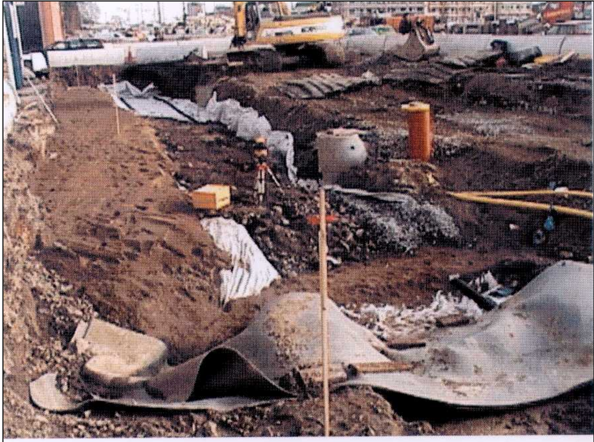
Figur 3 Anläggande av skelettjordsanläggningen, 2001
